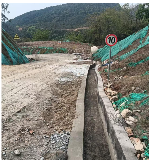
图 2-3 运矿道路限速标识牌、排水沟
